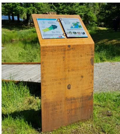
*Autres exemples de pupitre en acier corten avec classeur formé de plaques de dibon imprimées et panneau fixé sur un garde corps (Latronquière - 46)*
