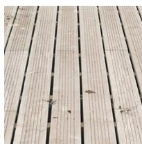
Platelages de bois brut imputrescible (type Robinier, Chêne ou Châtaigner) pour la création de passerelles piétonnes de découverte du site antique et pour habillage des pontons en traversée des ruisseaux
