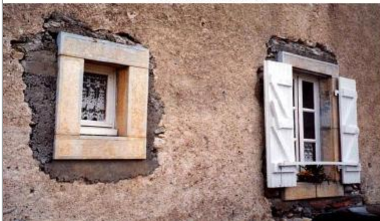
Détails d'ouverture en cours de restauration
