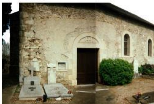
Vue du portail au Sud
