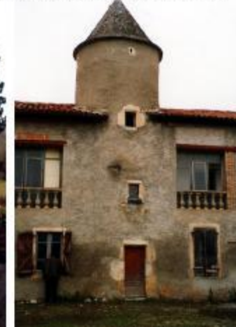
Tour médiévale de la maison Bordère
