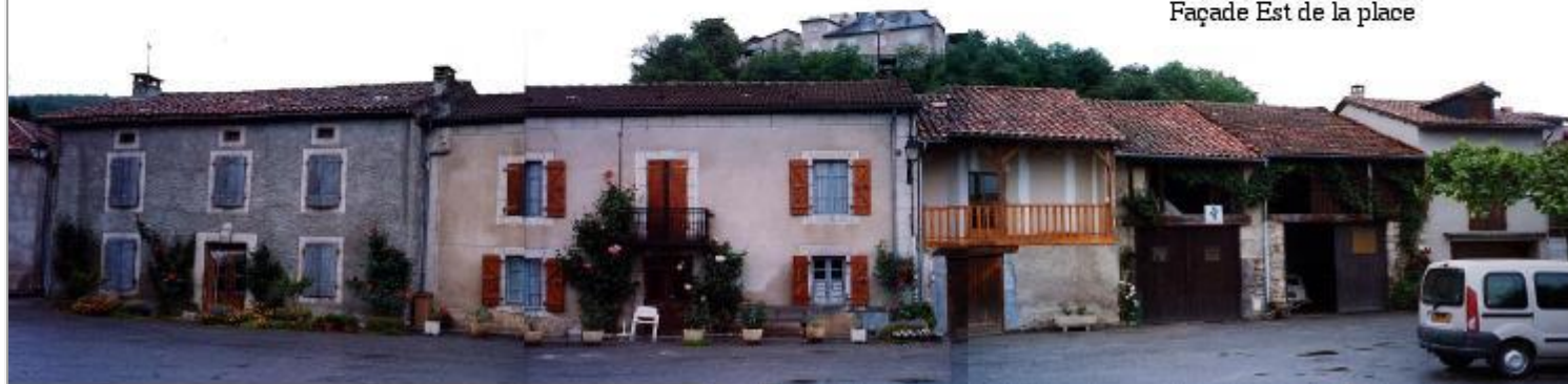
Façade Est de la place
